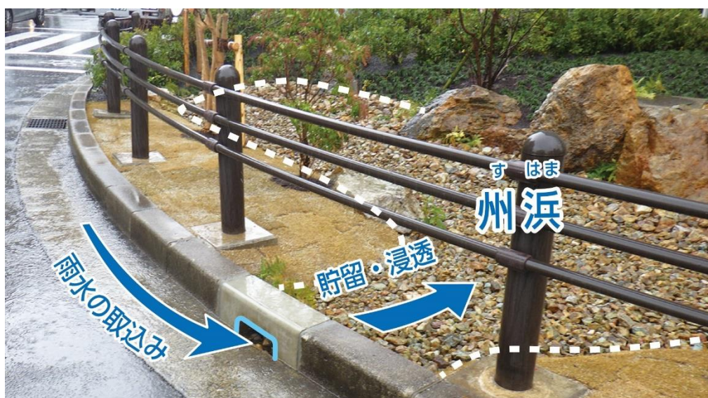
写真7. 京都市が整備している雨水貯留設備(雨庭) (出典：京都市建設局HP https://www.city.kyoto.lg.jp/kensetu/page/0000291580.html )
