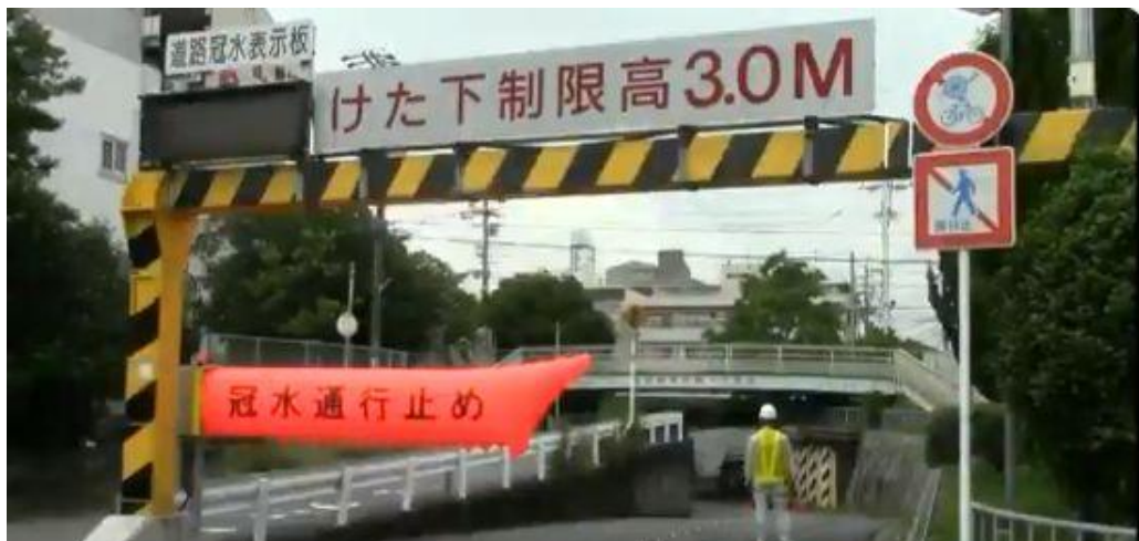
写真5. アンダーパス入口のエアー遮断器 (出典：大阪府豊中市公式広報Twitter)
