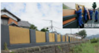
自主防災活動による畳堤設置 (堀保川水系、たつの市)
