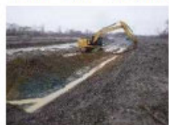
河道掘削 (石狩川水系、北海道開発局)
