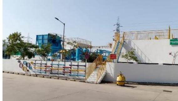
インドのタイヤ工場では、工程排水と生活排水を処理する排水処理施設を導入し、敷地内の植物への灌水で再利用
