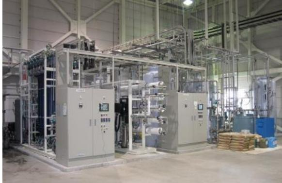
北九州工場では、排水クローズド化を進め、水の循環利用を推進(水の8割を循環利用)
