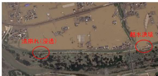
図-2 抽出可能な変状（光学）
