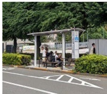
⑧遮熱舗装・減熱ベンチ
