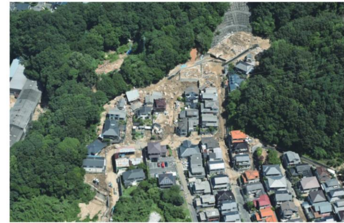
土砂崩れ（広島県広島市安芸区）
