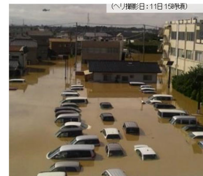
常総市役所から駐車場を撮影(撮影日: 9/11) 周辺は浸水し、防災拠点の市役所も孤立化。
