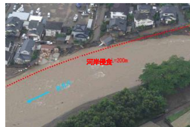
河岸侵食に伴う家屋倒壊 12
