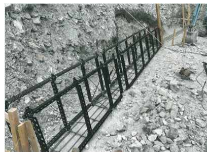
軽量で運搬や施工性に優れた資材による土留工の施工
