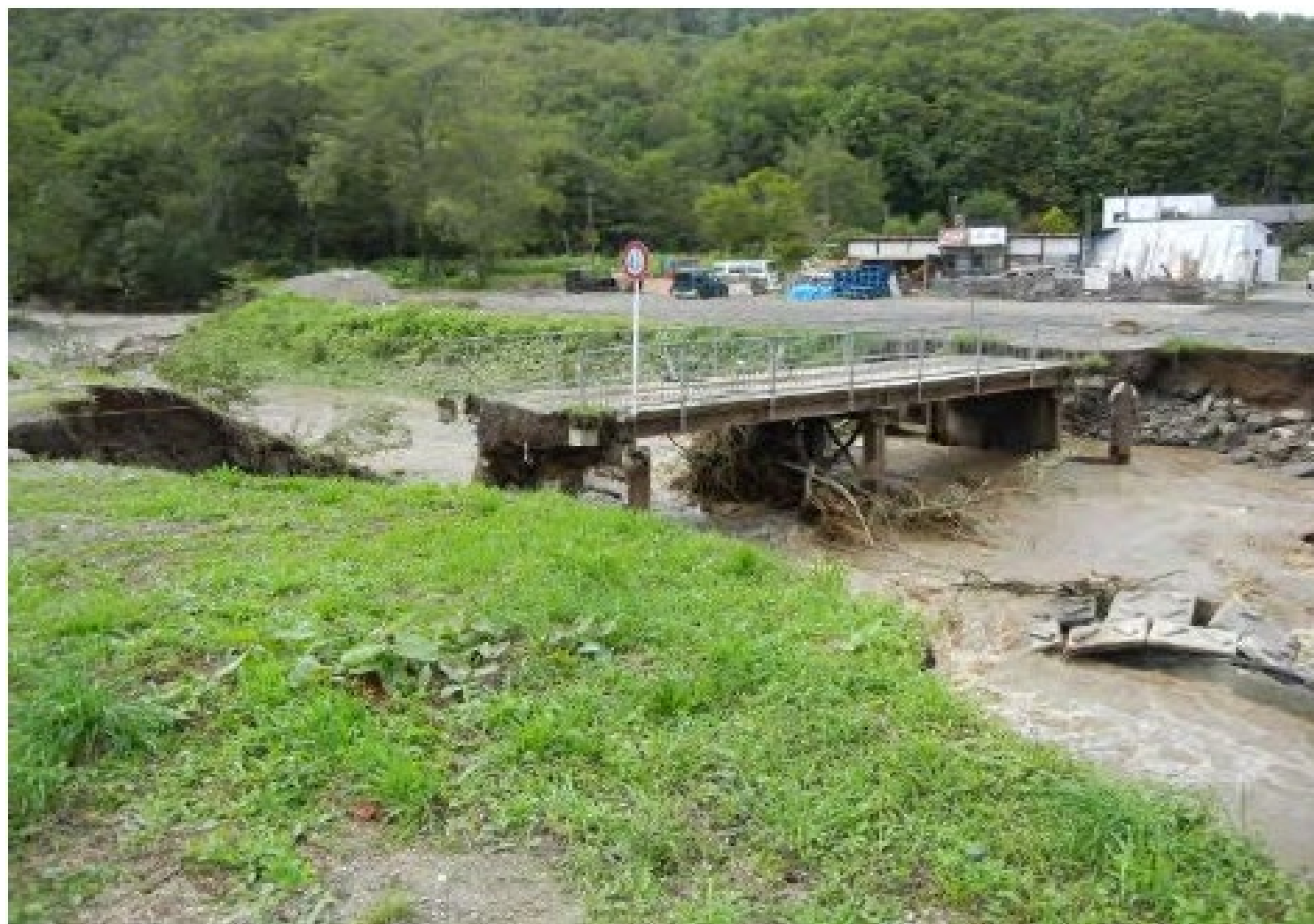
豪雨による橋の損壊 (2014年9月11日 札幌市清田区)
