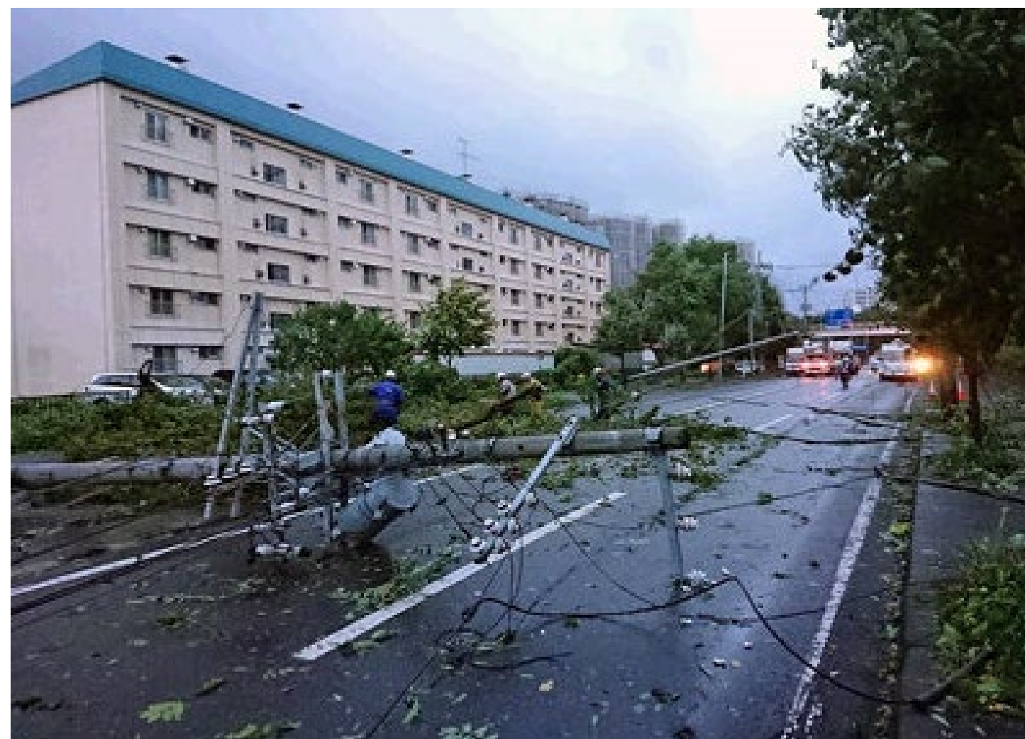
台風21号による電柱・樹木の倒壊 (2018年9月5日 札幌市北区)
