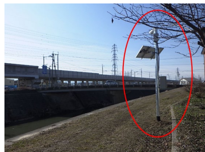
簡易型河川カメラの設置
