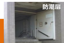
地下鉄出入口の浸水対策
