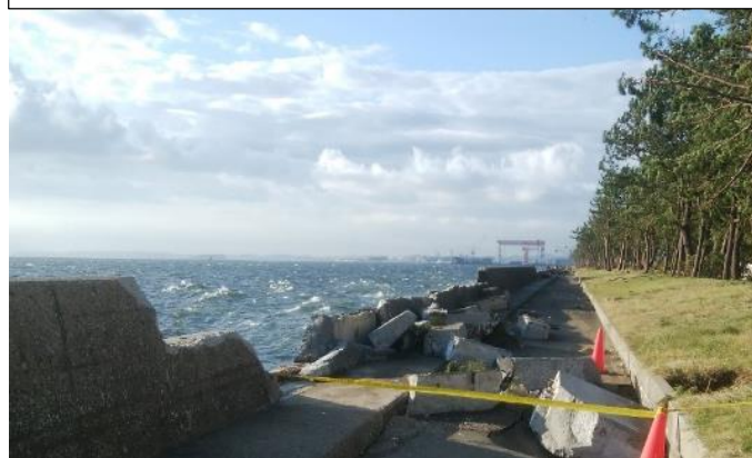
護岸の損傷（横浜港）
