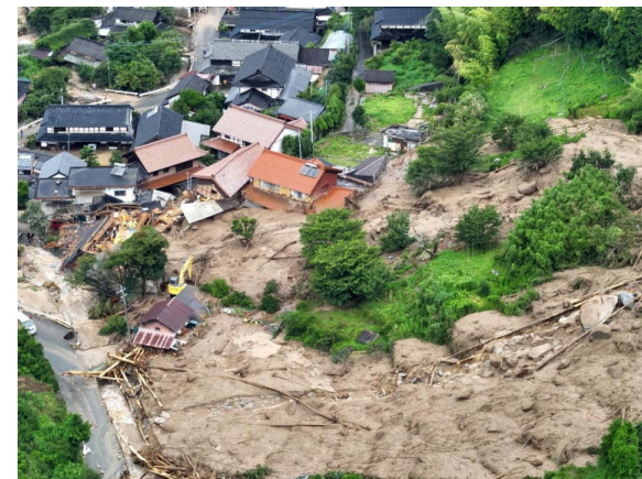
大雨による土砂災害
