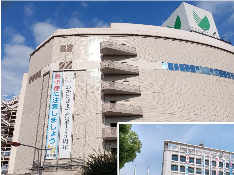
▲垂れ幕 八木橋百貨店【熊谷市】
