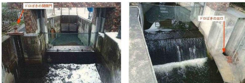
図 7-49 水門のドロばきの様子
