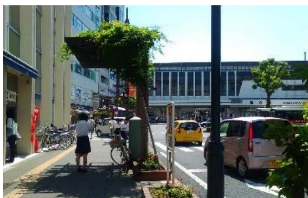
図 歩道に設置した藤棚 (埼玉県熊谷市) 出典：まちなかの暑さ対策ガイドライン (平成30年3月 環境省) より
