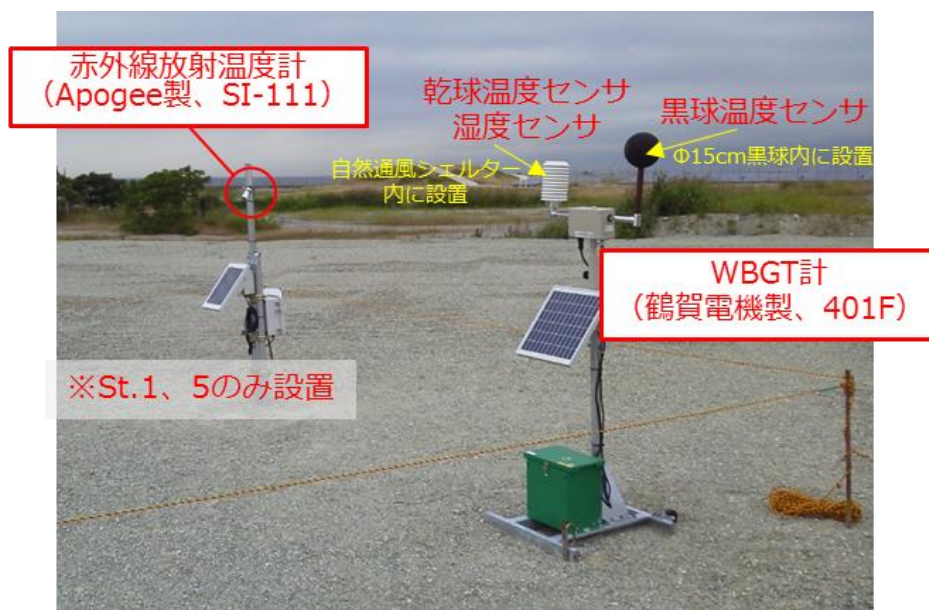
図 7.3-4 機器設置状況の例(St.1)
