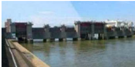
例: 愛知県 日光川水閘門
