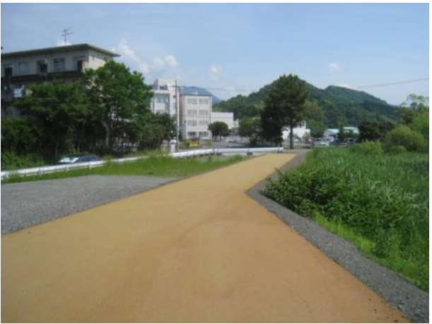
天端舗装（第3工区）
