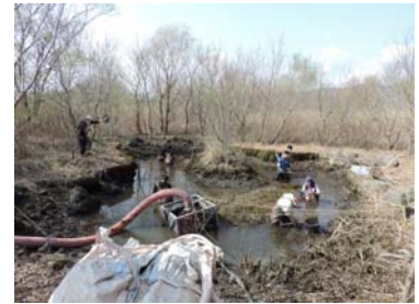
池の水抜きと底泥除去
