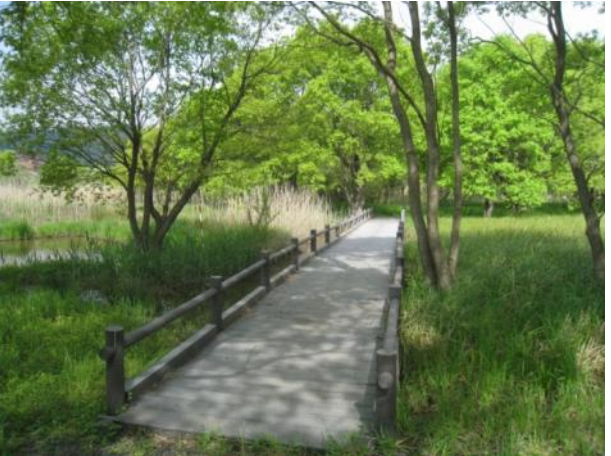
木道の整備（第3工区）
