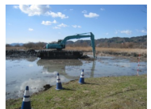
池沼部の掘削（第3工区）
