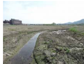
整備した水路
