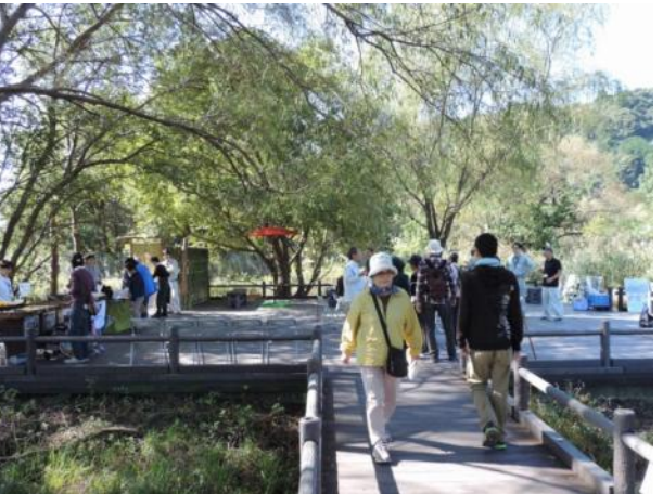
木道・デッキの整備（第4工区）
