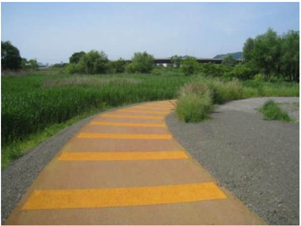
斜路の整備（第3工区）
