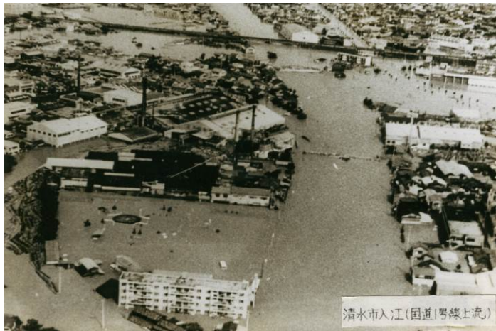
清水区入江 ー国道1号付近ー
