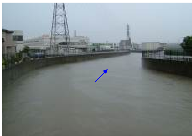
大谷川放水路 -葵区古庄-
