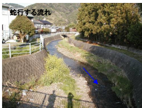
図 2-38 上流部の河道の状況 - 葵区北 -
