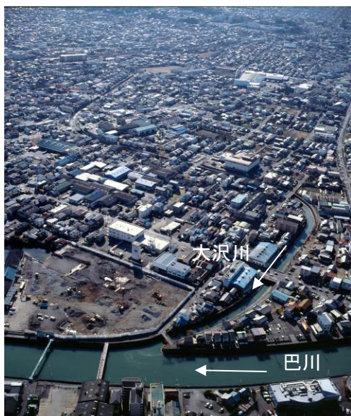
図 1-57 大沢川下流部 -清水区東大曲町付近-
