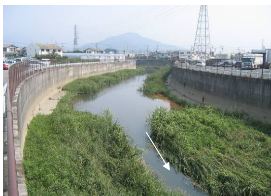
大谷川放水路 -葵区古庄 2 丁目
