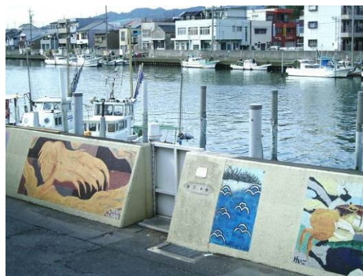
パラペット堤 -津波対策-
