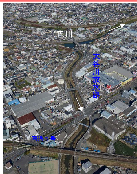
大谷川放水路分流堰 -葵区古庄-
