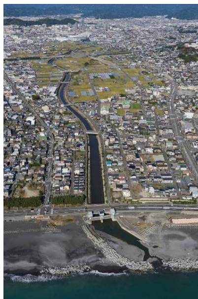
大谷川放水路河口部 -駿河区大谷-
