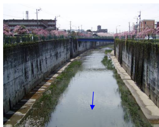
図 2-46 大谷川放水路の状況 - 駿河区小鹿 -
