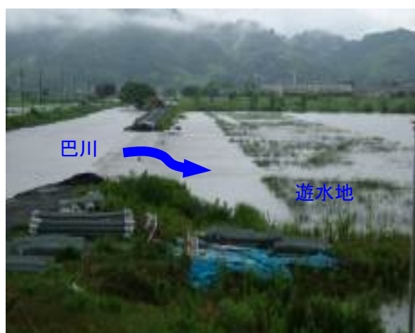
麻機遊水地第3工区 -葵区牛田-
