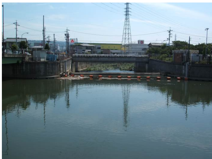
大谷川放水路分流工 -葵区古庄-
