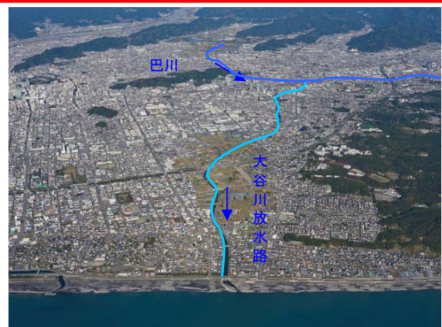
図 1-8 大谷川放水路全景
