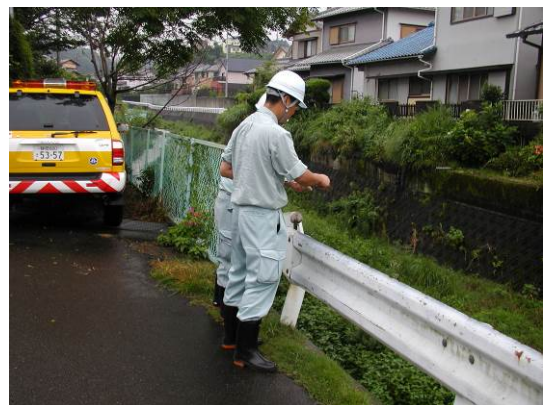
図 4-20 河川パトロールの状況
