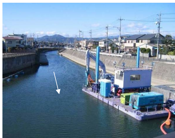
図 2-32 河川浄化の状況 (底泥の浚渫)
