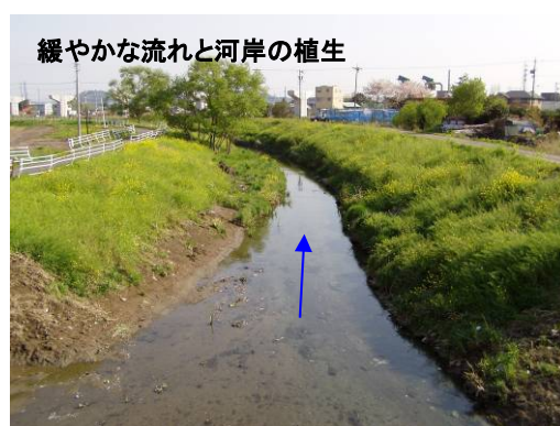
図 2-40 中流部の河道の状況 - 葵区漆山 -
