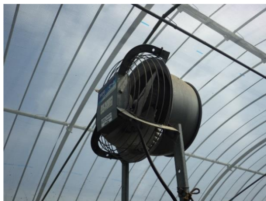
ハウス内に設置している循環扇
