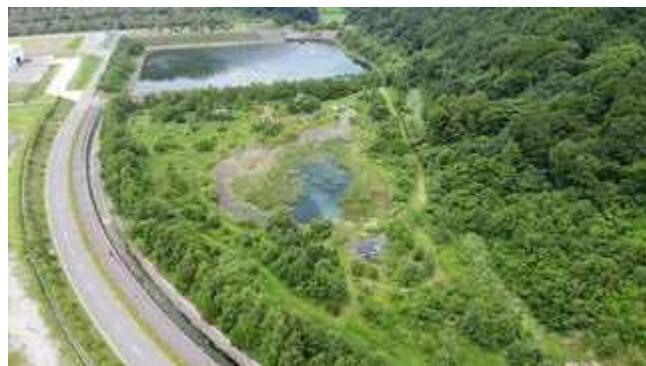
多奈川ビオトープの全景
