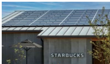
道の駅みのりの郷東金店 太陽光パネル
